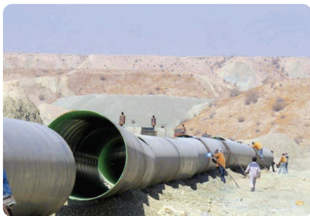
پروژه خط انتقال آب ۱۶۰۰ میلی متر از خلیج فارس به صنایع جنوب شرق کشور به طول ۳۰ کیلومتر و ۷ ایستگاه تلمبه خانه محل: بندرعباس
