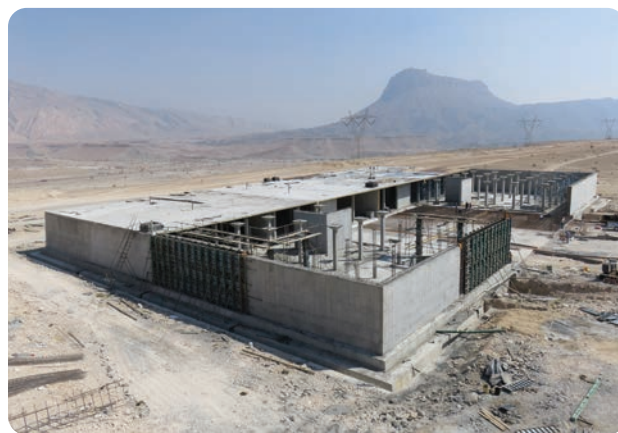
پروژه خط انتقال آب ۱۶۰۰ میلی متر از خلیج فارس به صنایع جنوب شرق کشور به طول ۳۰ کیلومتر و ۷ ایستگاه تلمبه خانه محل: بندرعباس
